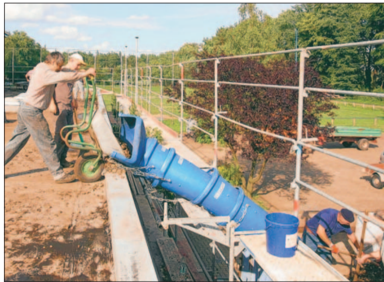
Die engagierten Bürger hatten Glück und konnten sich bei Sonnenschein an die Dacharbeiten machen. —FOTO: VAN
