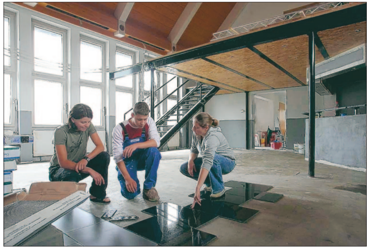
Welche Fliesen kommen in das neue Jugendzentrum? Jasmin Westerman, Dominic Pfirrmann und Julia Westermann sind mit Feuereifer bei der Arbeit. —FOTO: VAN
